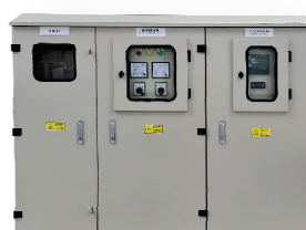
Tủ cầu dao điện kế
