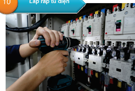
10 Lắp ráp tủ điện
