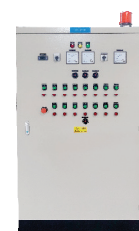
Tủ điều khiển
