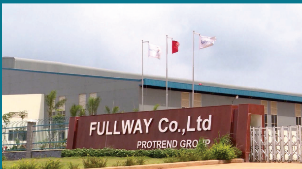
Dự án: NHÀ MÁY FULLWAY VIỆT NAM.
